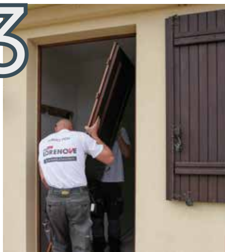
Dépose de l'ancien ouvrant
