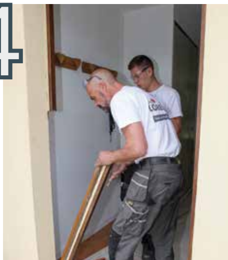
Dépose de l'ancien dormant
