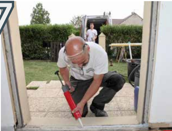
Réalisation de l'étanchéité
