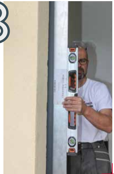
Contrôle du niveau
