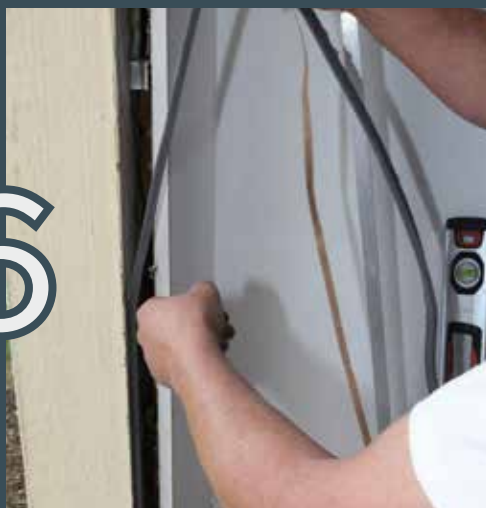
Pose du fond de joint
