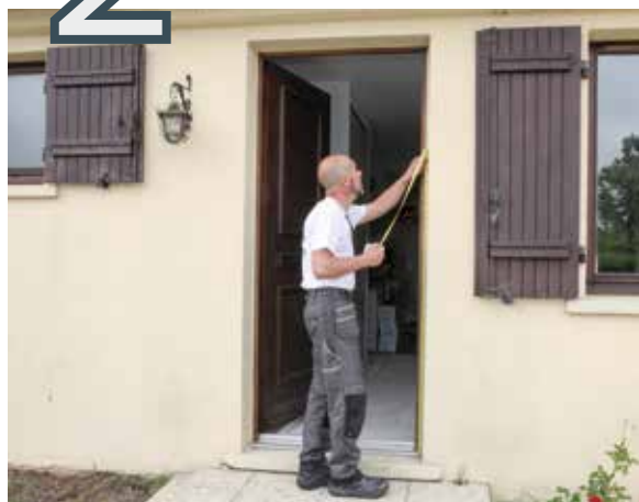
Vérification des dimensions
